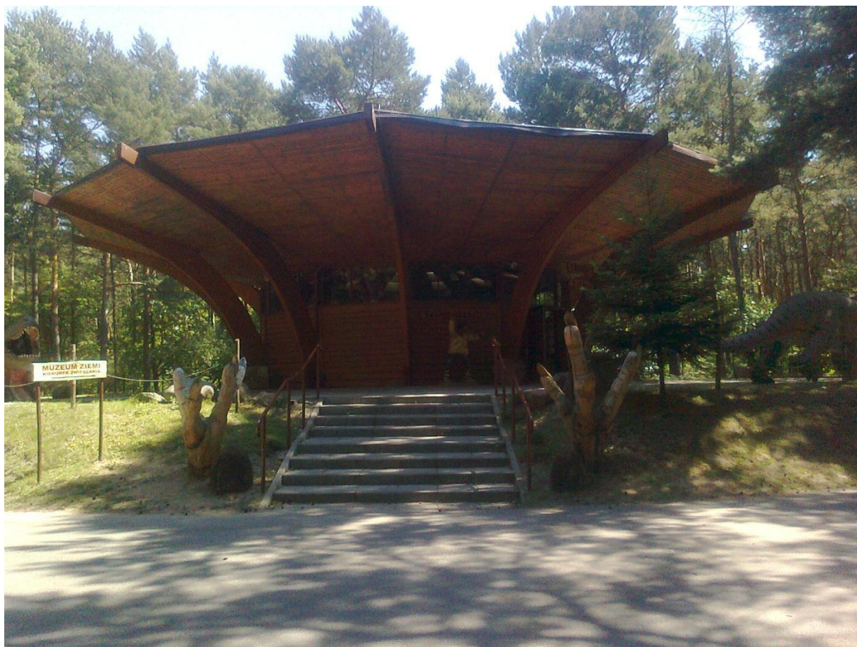
Fotografia 1: Budynek wystawienniczy – elewacja frontowa.
